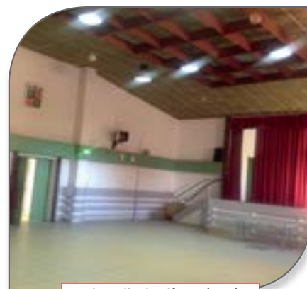
→ La salle des fêtes rénovée
