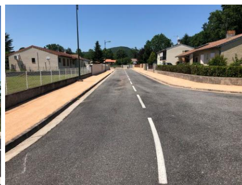
Les trottoirs dans 4 lotissements.....
